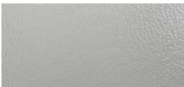
施工後の表面
