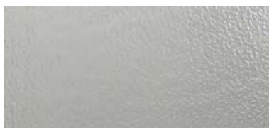
施工後の表面
