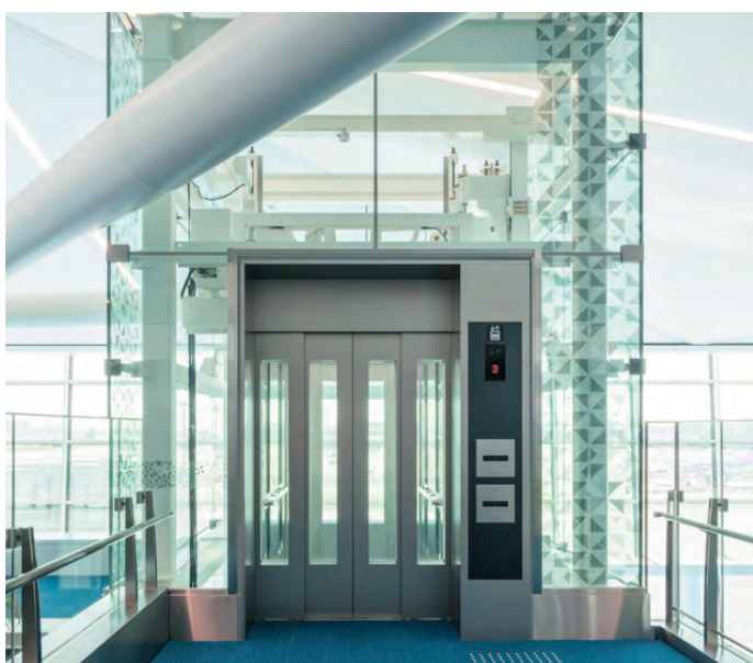
物件名：東京国際空港国際線ターミナル再拡張 (II工区) 設計・監理：梓・安井・PCPJ 東京国際空港国際線旅客ターミナル 設計監理共同企業体 品番：特注デザイン (EV昇降路ガラス面)
