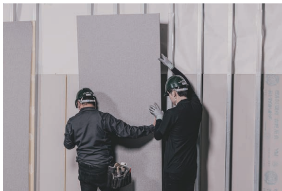
壁紙と石膏ボードを一体化し、建設現場における壁面施工の工程を短縮
