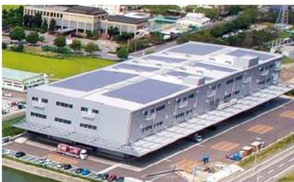
2014年に愛知県稲沢市に位置する当社の物流拠点中部ロジスティクスセンター1の屋上に2,170m<sup>2</sup>の太陽光発電パネルを搭載し、自然エネルギーの有効活用に取り組んでいます。2021年度は、499,300kWhの電力を発電しました。これは、一般家庭の163世帯の年間電力量に相当します。
